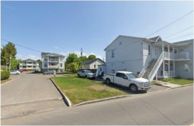
Vue depuis la rue Saint-Jacques _ Cadre bâti existant Orientation depuis nord-est Source : Google Street View
